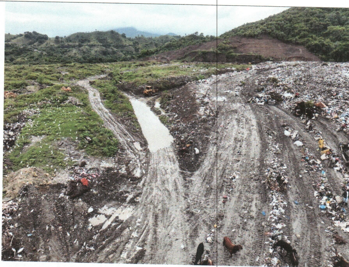
Fotografía aérea del área de vertido en el Vertedero Municipal de Puerto Plata
