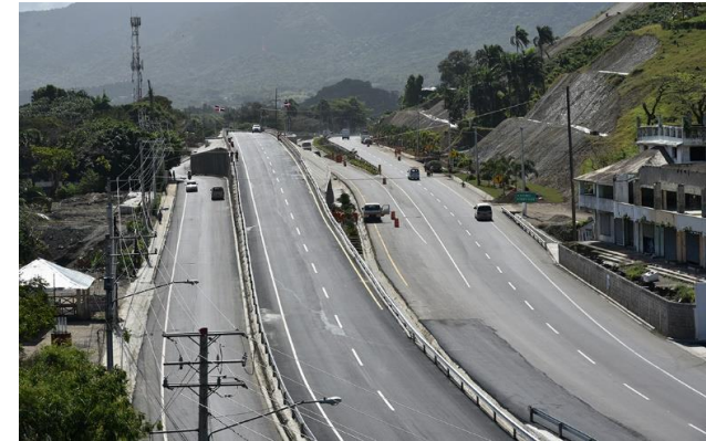
Fotografía 2 Vía Navarrete-Puerto Plata. www.depuertoplata.com
