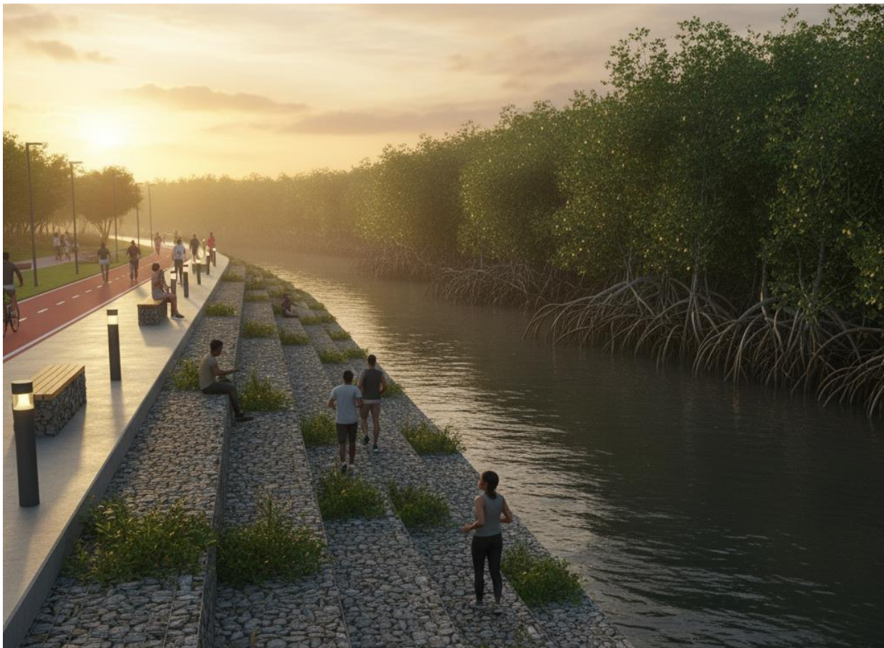
Figura 15. Propuesta para la implementación de gaviones vegetados en puntos críticos del río San Marcos.
